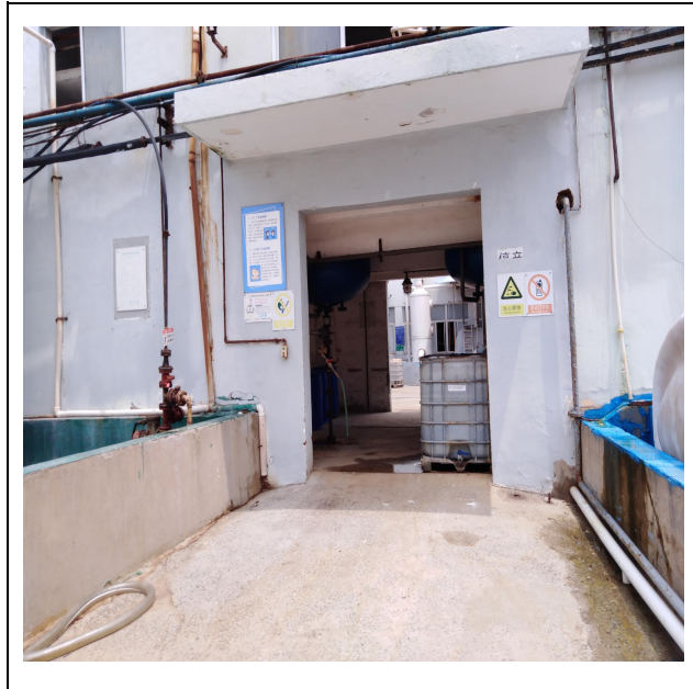
图 5.1-2 原叔丁基二甲基氯硅烷车间A
